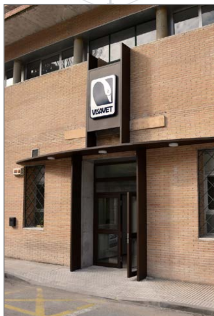
Obras de remodelación del acceso principal. Marzo 2016
